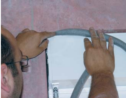
■ Verarbeitung Hinterfüllschnur
